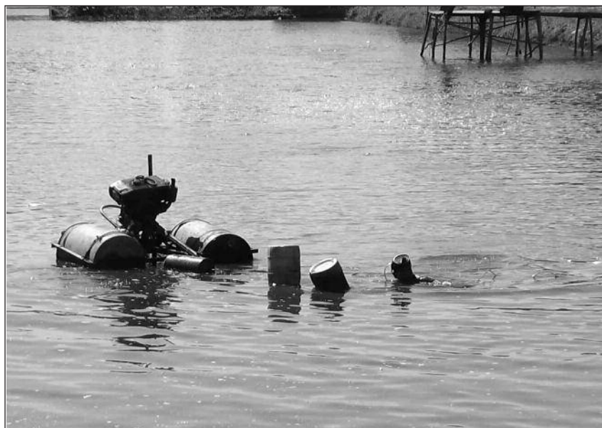
5. ábra: A panganevelő tavakból búvárok zagyszivattyúkkal távolítják el fenéken felhalmozódott szerves anyagot
