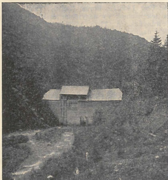
2. kép. Vízyűjtő-gát a Janovec-patakon.
