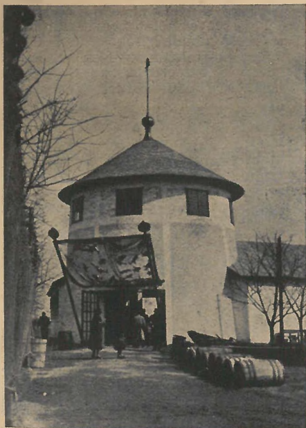
9. kép. A halászati pavillon bejárata.
